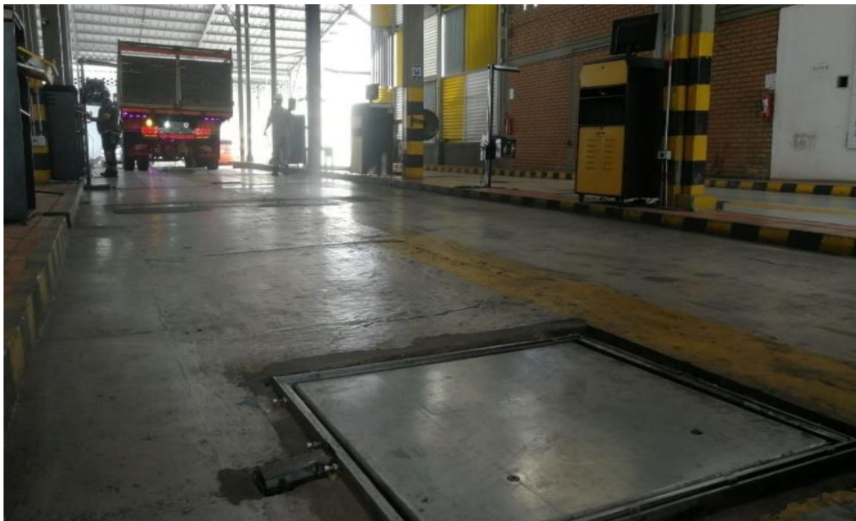
Imagen 1. Estado actual pista mixta.
